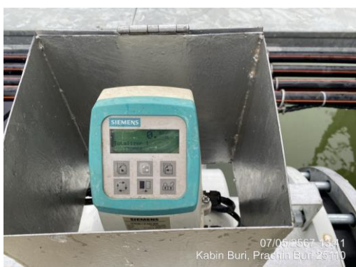
(7) เครื่องตรวจวัดอัตราการไหลของน้ำทิ้ง
