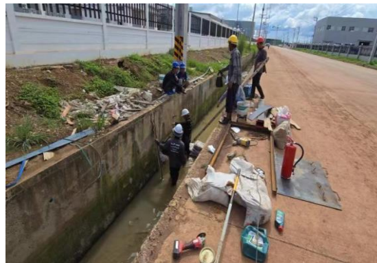
(27) การทำความสะอาดรางระบายน้ำของโครงการ
